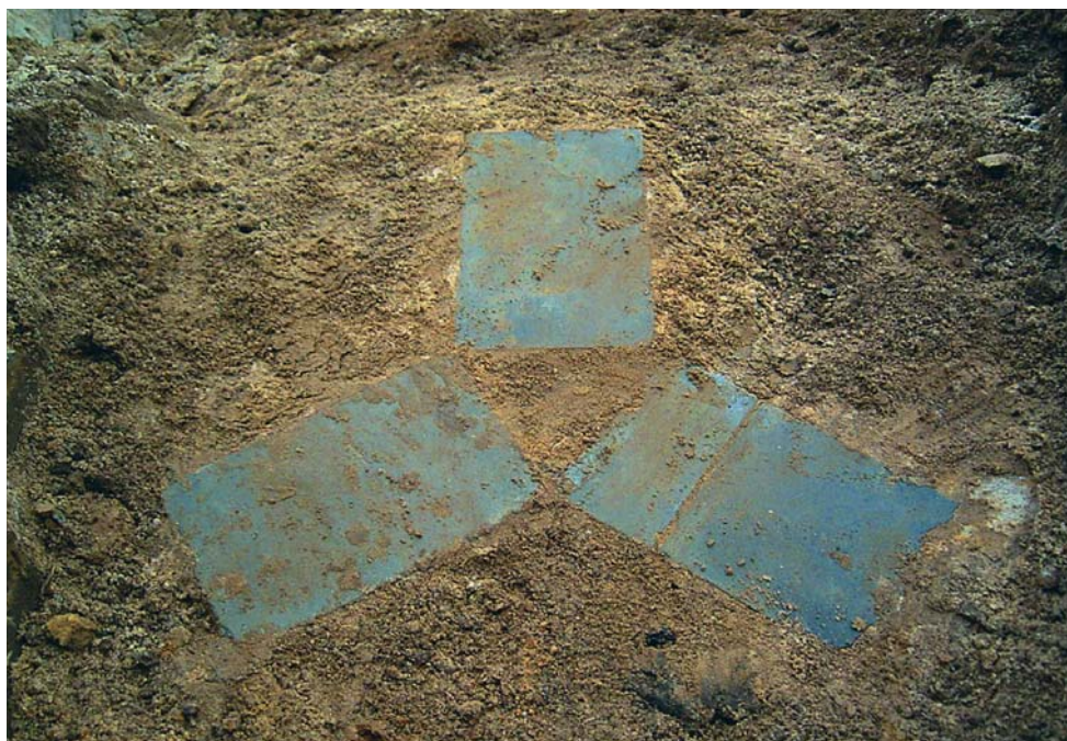
▲ Układ bloczków betonowych stanowiących podstawę pompy przypomina logo „mercedesa”
