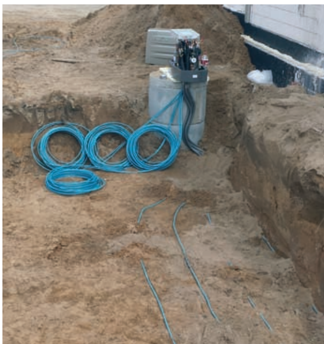
5. Prace ziemne związane z montażem kolektora gruntowego rozpoczyna się od wybrania ziemi w pobliżu fundamentu – zanim zostanie na nim posadowiona pompa ciepła. Po ustawieniu i zamocowaniu pompy należy zaizolować na odcinku ok. 2 m schodzące na dno wykopu rury zasilania i powrotu kolektora gruntowego. Zapobiegnie to zbyt niemu przemrożeniu gruntu w miejscu, gdzie zbiegają się wszystkie pętle kolektora.
