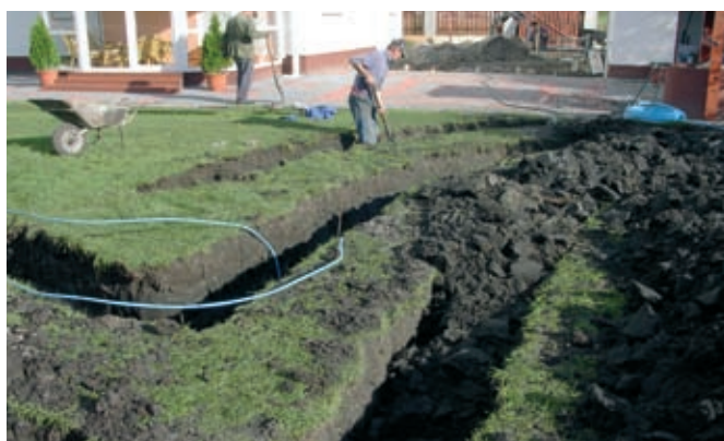
6. Teraz można przystąpić do prac związanych z ułożeniem pętli kolektora gruntowego. W zależności od warunków gruntowych oraz występujących ograniczeń (np. istniejące ogrodzenie działki, zabudowa terenu) pętle można rozkładać w wykopach przestrzennych, bądź w rowach przygotowanych pod pojedyncze wiązki. Pętle rozkłada się na głębokości 1,2–1,8 m, zależnie od strefy przemrażania gruntu. Generalnie obowiązuje zasada, że układa się je ok. 30 cm poniżej tej strefy. Rury kolektora bezpośredniego parowania w technologii NDX układa się w odstępie co 60–70 cm. Ponieważ są bardzo elastyczne, można je układać w wykopie o niemal dowolnym kształcie, niemniej jednak należy uważać, aby ich nie zagiąć.
