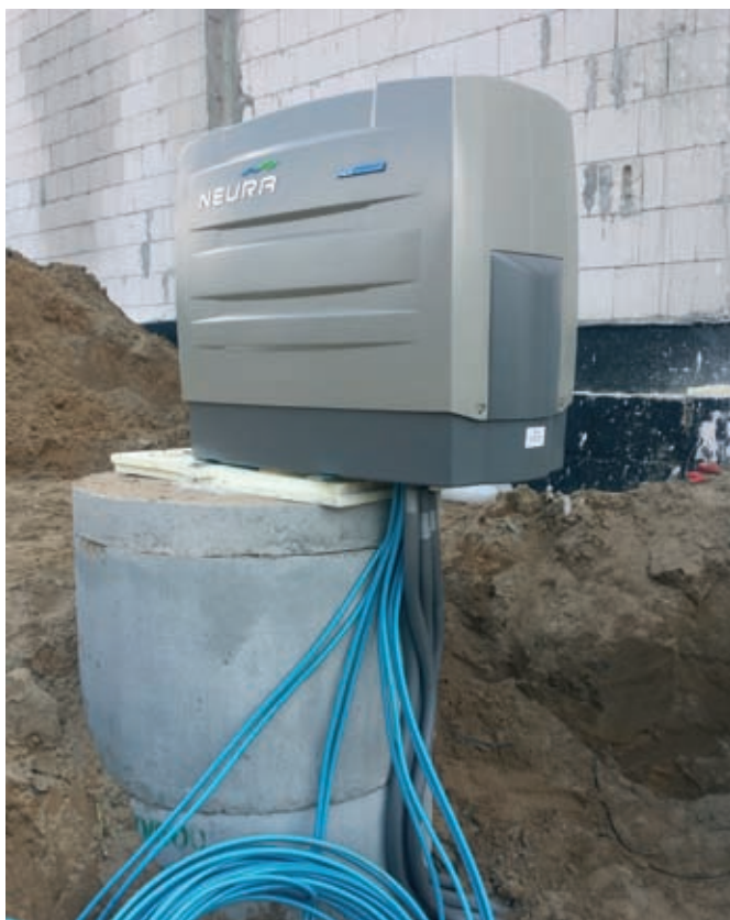
4. Pompę ciepła przymocowuje się do fundamentu śrubami – przez znajdujące się w niej uchwyty. Na fundamencie, pod pompą ciepła, trzeba jednak wcześniej położyć płytę polistyrenową grubości 5 cm, która zabezpieczy przed przenoszeniem się drgań na fundament oraz instalację c.o.
