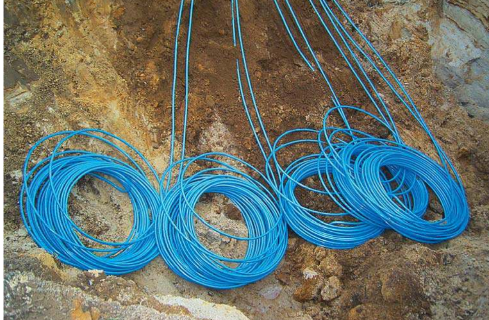
▲ Tuż za pompą ciepła rurki kolektora gruntowego „schodzą” pod ostrym kątem na głębokość roboczą (1,5-1,8 m)
