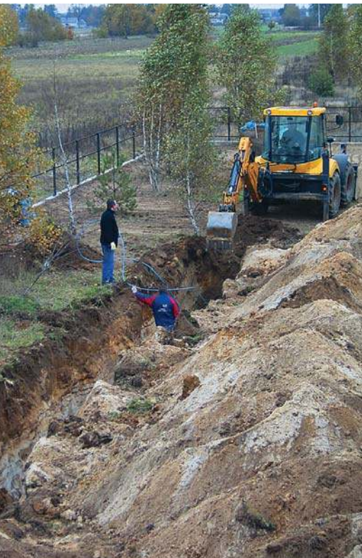
Wykop pod jedną nitkę kolektora miał długość około 40 metrów ▼
