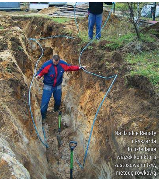
Wykop pod jedną nitkę kolektora miał długość około 40 metrów ▼
