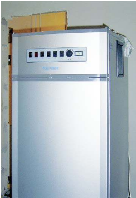
▲ Podgrzewacz wody użytkowej wyprodukowany przez duńską firmę VESTTHERM. Jego najważniejszą część stanowi niewielka pompa ciepła typu powietrze-woda. Przygotowuje ona ciepłą wodę użytkową wykorzystując do tego celu odpowiednio wysoką temperaturę powietrza panującą w pomieszczeniu, w którym się znajduje. Wystarczy już około 5°C, aby pompa skutecznie spełniała swoje zadanie
